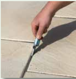
Hierzu Schnittkante FugenBand einkerben
