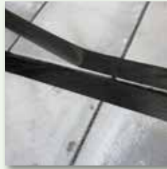
Fugenraum säubern und Kanten abkleben
