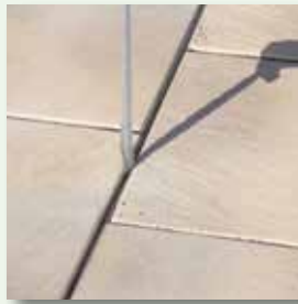
Fugenbandreste komplett entfernen
