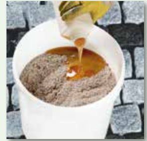
Bindemittelkomponente zugeben
