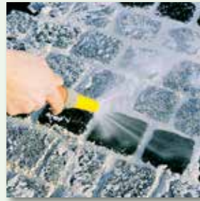
mit Wassersprühstrahl und feuchtem Besen abreinigen
