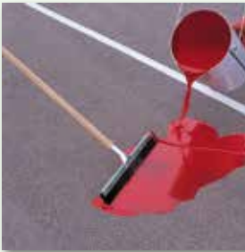
Material vollständig ausbringen und mit Gummischieber verteilen
