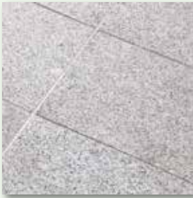
Klebebänder direkt im Anschluss entfernen; Nachbehandlung beachten
