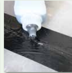
Ggf. umfüllen in die Flasche und vergießen
