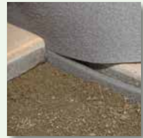
vdw 884 FugenBand 10 mm tief abtrennen
