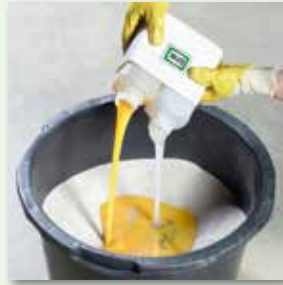
Die beiden Bindemittelkomponenten zumischen
