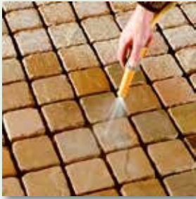
Fläche rückstandsfrei reinigen und vornässen
