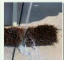
Besen öfter ausspülen – somit nimmt dieser mehr Mörtelreste von der Oberfläche auf und erleichtert die Reinigung
