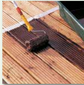
Auftragen der Decksicht mittels Fellrolle und ...
