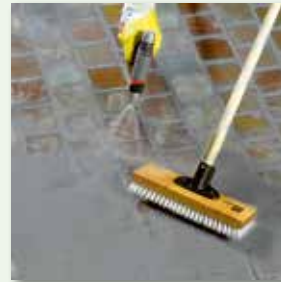
diagonal zur Fuge abreinigen
