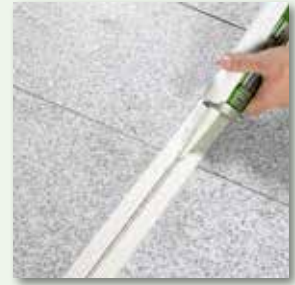
Fugenmasse einbringen
