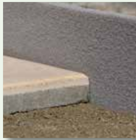
Anschließenden Belag druckfrei verlegen
