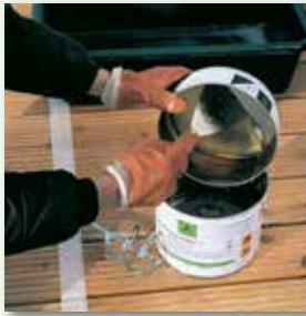
Frühens nach 4 Stunden die Komponenten der Decksicht wie die der Schwimmschicht aufmischen
