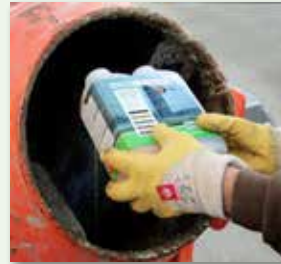
Bindemittelkomponenten zugeben
