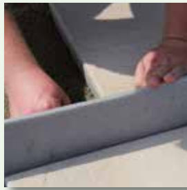
vdw 884 FugenBand im Bettungsmörtel einbringen
