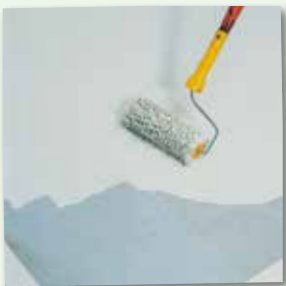
Die 2. Applikation frühestens nach ca. 12 Stunden auftragen
