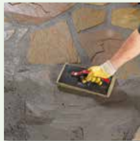
diagonal zur Fuge abreinigen
