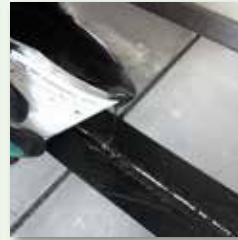
vdw 380 PolyfugenFlex in die Fuge gießen
