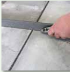
Dehnungsfugenband \geq 10 mm tief freischneiden
