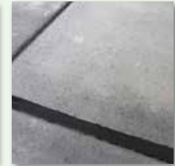
Vor der Aushärtung Klebebänder entfernen
