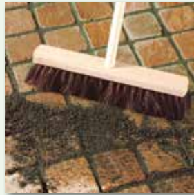
Mittels feuchtem Besen abfegen
