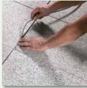
Fugentiefe durch PE-Rundschnur fixieren
