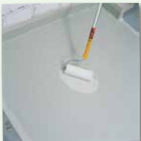
... und mit Fellrolle verteilen
