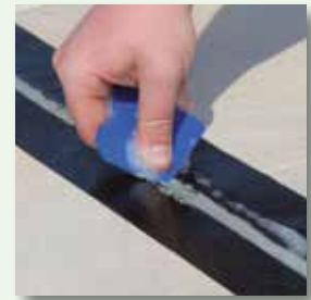
Fugenmasse verdichten und abziehen
