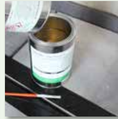
vdw 381 PolyPrimer P (hier für saugende Untergründe) aufbereiten
