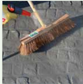
Erhärten des Mörtels auf der Oberfläche vermeiden
