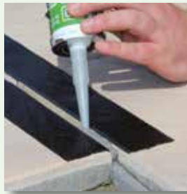
Kanten sauber abkleben und vdw 885 plus FugenFlex mit Druck blasenfrei einspritzen
