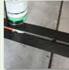
Fugenflanken mit Primer grundieren
