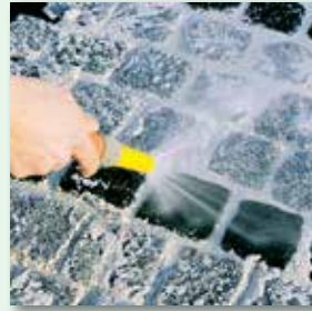
mit Wassersprühstrahl und feuchtem Besen abreinigen
