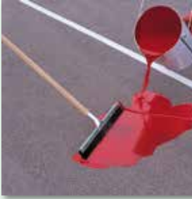
Material vollständig ausbringen und mit Gummischieber verteilen
