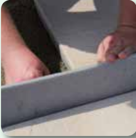
vbw 884 FugenBand im Bettungsmörtel einbringen
