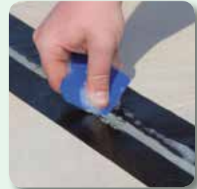
Fugenmasse verdichten und abziehen
