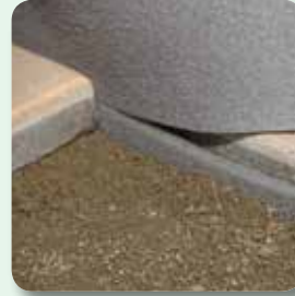
vbw 884 FugenBand 10 mm tief abtrennen
