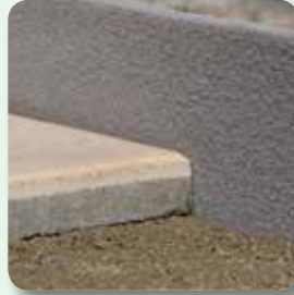
Anschließend Belag druckfrei verlegen
