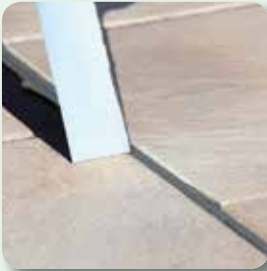
Klebebänder direkt im Anschluss entfernen
