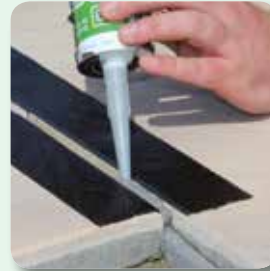
vbw 885 FugenFlex mit Druck blasenfrei einspritzen
