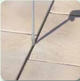
Fugenbandreste komplett entfernen
